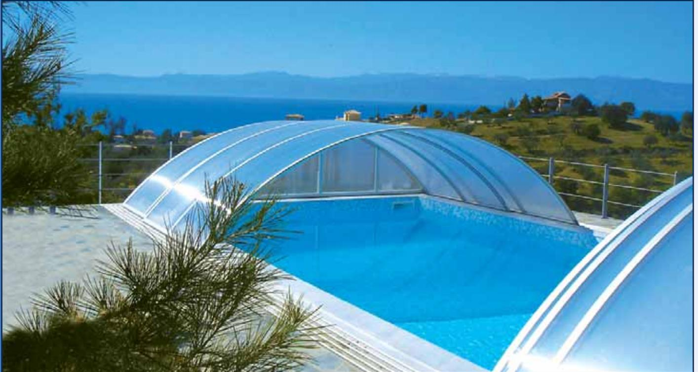
Bogenprofile eloxiert, Dachfläche und Rückwand aus 8 mm Doppelstegplatten
