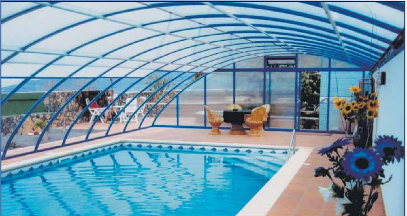
Bogenprofile in RAL 5011, Dachfläche und Stirnwände aus 8 mm Polycarbonat-Doppelstegplatten
