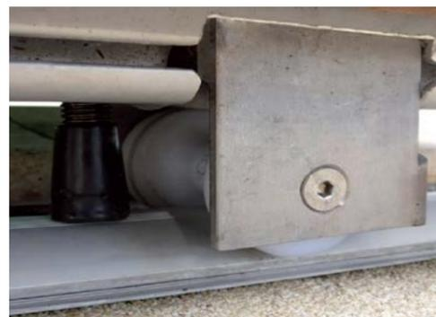
Bremse mit Gummibacke und Führungsrad
