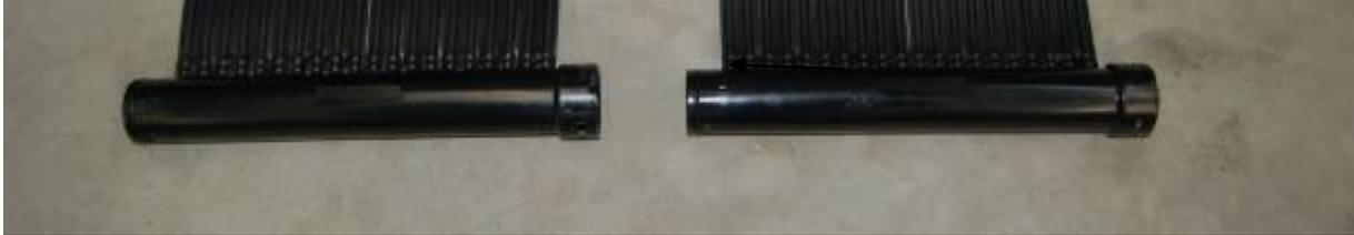
1. Bringen sie die Dichtungsringe an den Enden an und verbinden Sie die Rohre. Mit Hilfe von ein bisschen Seife wird das Verbinden vereinfacht. Nach dem Zusammenschließen werden die Rohre mit den Verbindungsstücken gesichert.
