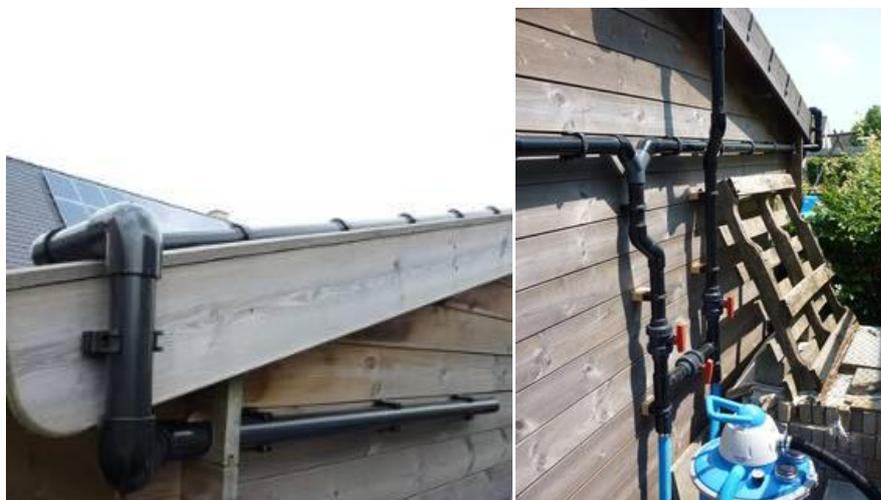
Die Kollektoren können mit oder ohne Bypass an einen Filter angeschlossen werden. Das Kit enthält keinen Bypass und wird daher immer funktionieren, sobald der Filter zu arbeiten beginnt. Erhöhen sie die Effektivität der Installation mit der Installation eines manuellen oder automatischen Bypass : dann werden die Kollektoren nur genutzt sobald deren Temperatur höher ist als die des Poolwassers.
