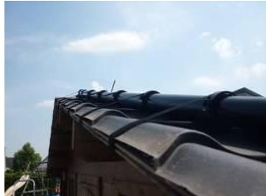
2. Die gesamte Anlage fixieren, indem es durch die Gummiteile gewebt wird. Man kann die Kollektoren natürlich auch direkt aufs Dach kleben (Silikone, VersaBond, ...)
